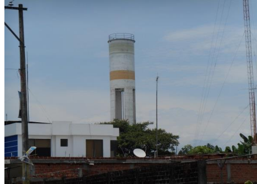
Foto. Pozo y tanque elevado en el otro sector
