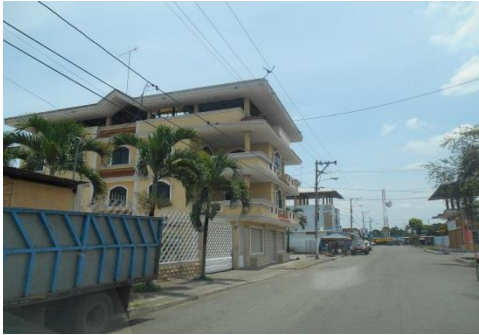
Foto. Edificaciones de 2 y 3 pisos.
