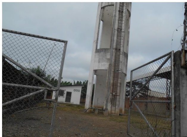
Foto. Área del pozo profundo y repartición de red de tuberías
