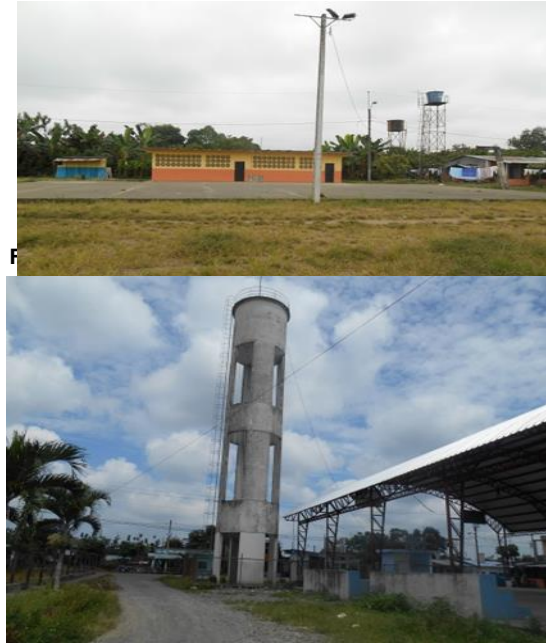
Foto. Sistema de agua del recinto San Francisco
